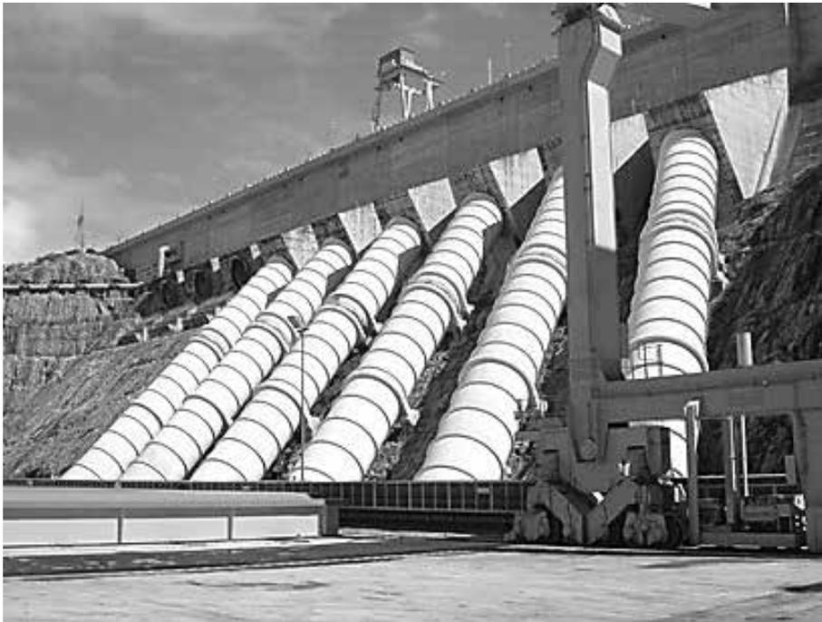
Figura 1.31 – Condutos forçados vistos de perto – central real
