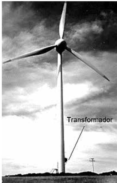
Figura 2.2 - Transformador individual na base da torre
