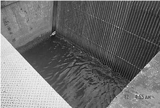
Figura 1.24 – Grades de proteção em central real
