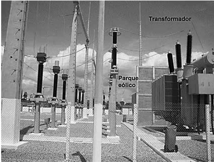
Figura 2.3 – Subestação de 230 kV conectada com parque eólico
