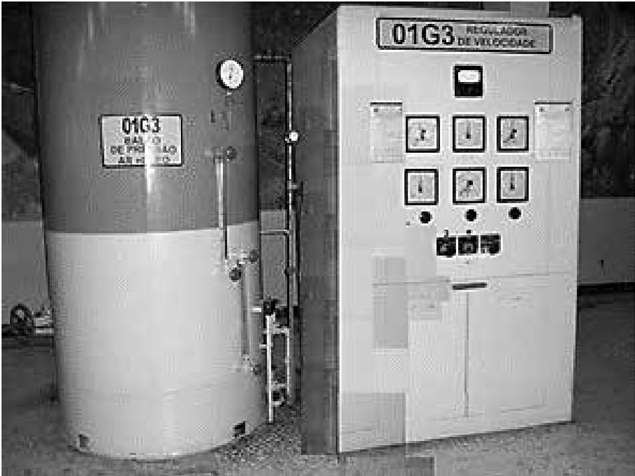
Figura 1.43 – Regulador de velocidade – parte externa
