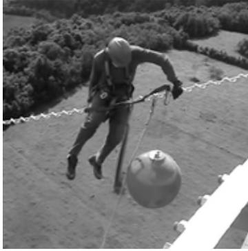
Figura 2.63 - Instalação da esfera de sinalização
