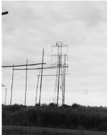
Figura 2.60 - Cavaletes montados para a travessia dos cabos sobre a rodovia
