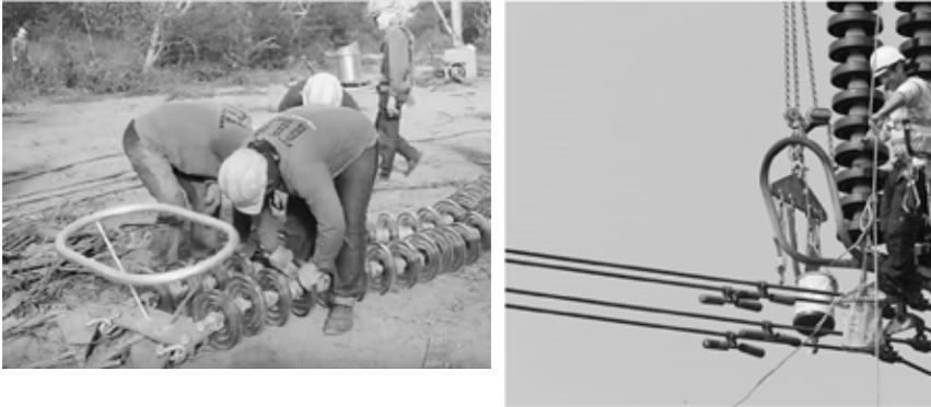
Figura 2.56(a), (b) - Instalação de isoladores
